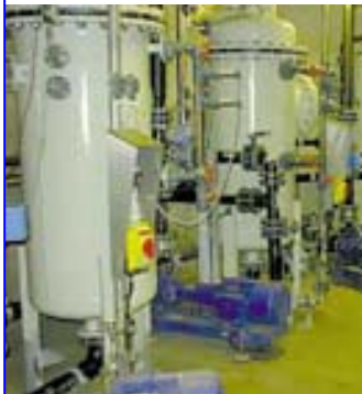
AQUATECTOR® saturador com pressão operacional de 3 bar
