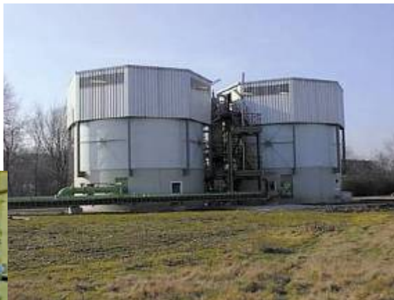
Dois tanques circulares de flotação de 10 m de diâmetro cada um
