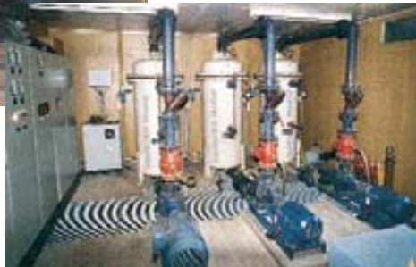
Saturador de pressão AQUATECTOR, para alimentar o tanque de flotação, dotado com sistema COMTECTOR para limpeza completamente automática de válvulas e injectores.
