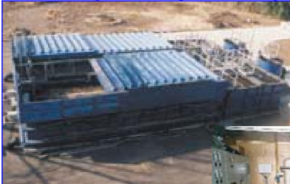
Dois tanques de flotação rectangulares
